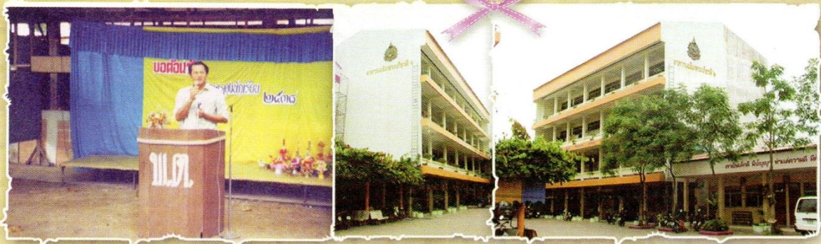
อาคารเฉลิมพระเกียรติ 1 และ 2
